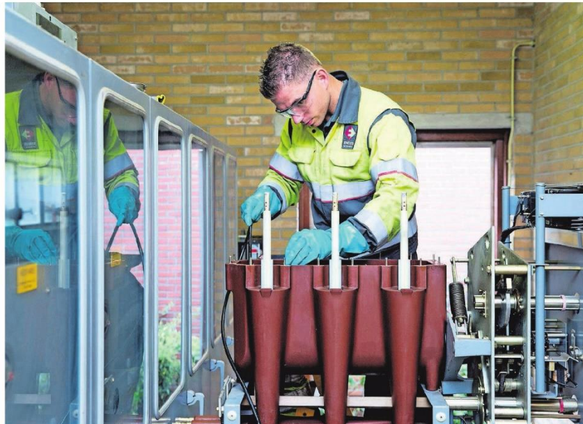
▲ Een monteur van Enexis aan het werk aan een hoogspanningsschakelaar. Enexis en Tennet moeten flink investeren om de capaciteit op het netwerk te vergroten. FOTO ENEXIS/JEAN-PIERRE JANS
